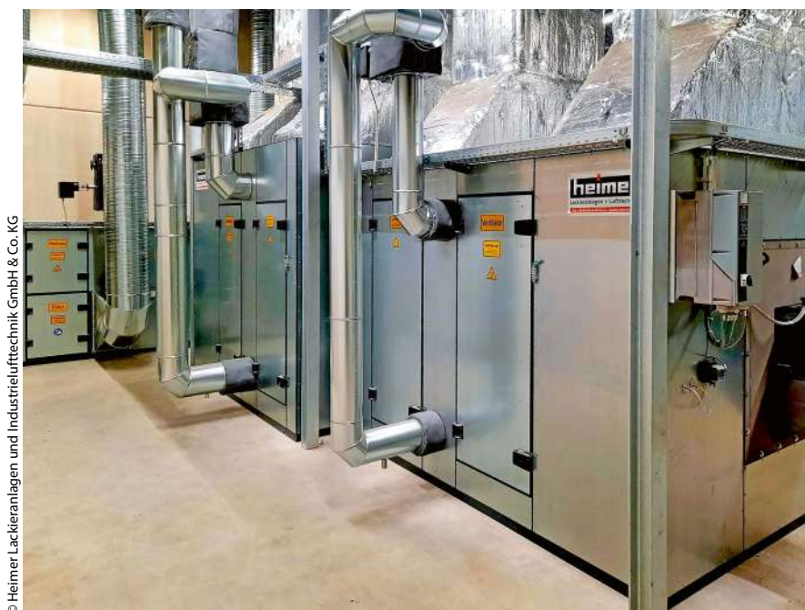
Umluftgeräte der Aufheiz- und Haltezone mit Thermalölbeheizung.
