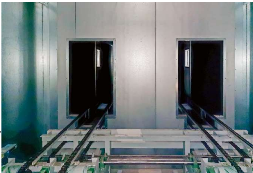
Einlaufbereich vor der Abdunstzone.
