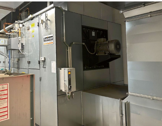
Lufttechnik der Lackierkabine in kompakter Bauweise mit Wärmerad und Heizeinrichtung in einem Gerät integriert.
